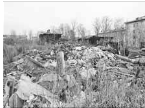
■ Набережная Северной Двины, 32
